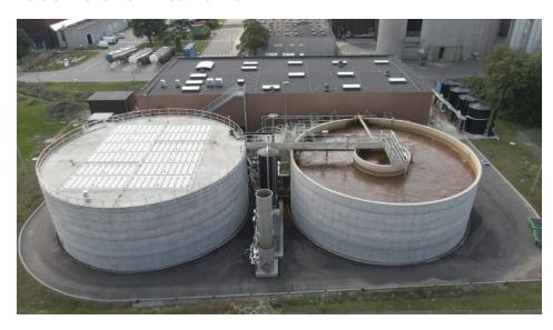
Die TWM-Anlage nutzt anaerobe und aerobe Verfahren zur Abwasseraufbereitung. Im anaeroben Becken auf der linken Seite wird Biogas erzeugt, das zur Generierung von Wärme für das Brauen genutzt wird (Bild: Grundfos).
