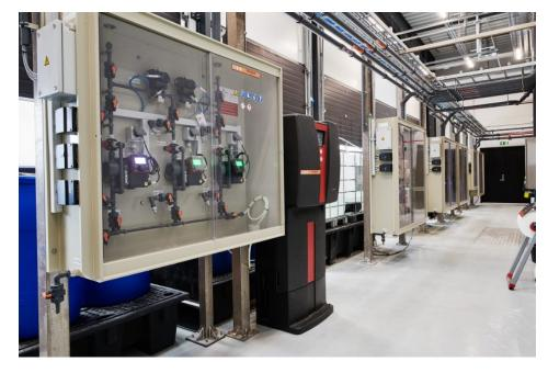
Grundfos lieferte eine Komplettlösung für das Dosieren: Schränke mit den Dosierpumpen, alle benötigten Rohrleitungen und Ventile. Die Pumpen sind mit einer Software zur Durchflussregelung ausgestattet, um exakt zu dosieren (Bild: Grundfos).
