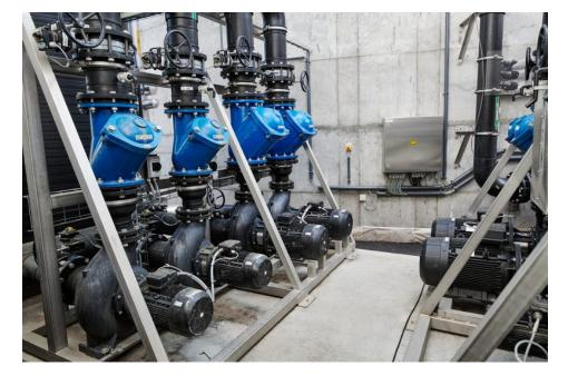
Vier »NB«-Pumpen von Grundfos zirkulieren das Wasser in und zwischen die anaeroben, aeroben und Konditionierungsbecken sowie zur Biogasspülanlage (Bild: Grundfos).
