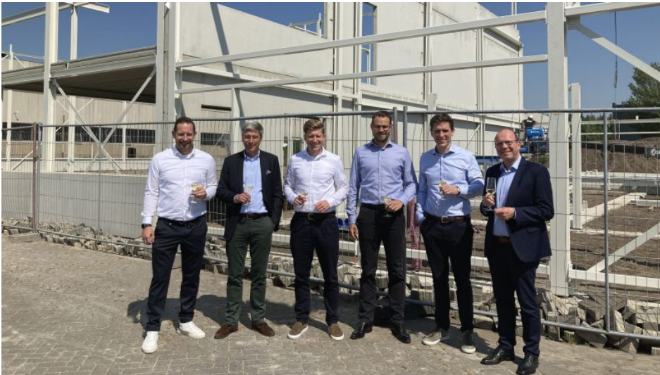
Bild von der symbolischen Grundsteinlegung am 9. Juni 2023 (Bild: Crespel & Deiters).
