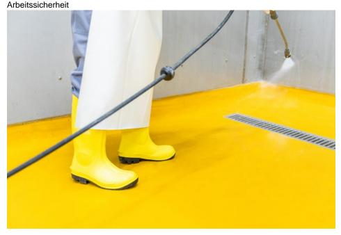
Von glatt bis strukturiert sind unterschiedliche Oberflächenrauigkeiten mit den jeweils erforderlichen Rutschhemmstufen realisierbar (Bild: Seitz + Kerler).
